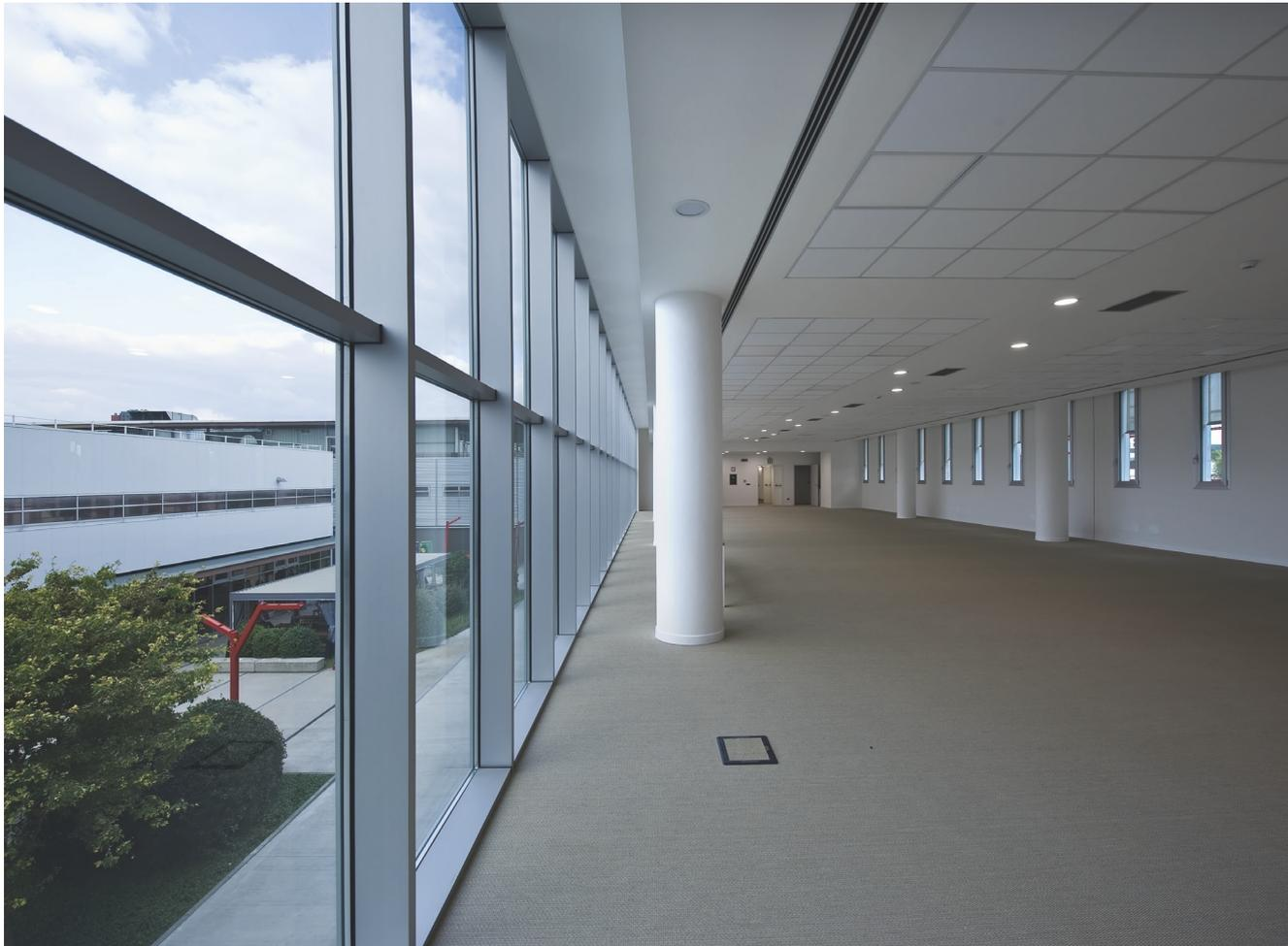
Ossatura portante a telaio e successiva chiusura sia esterna sia interna con stratificazioni materiche completamente a secco per l'involucro prestazionale studiato da Vanoncini ad hoc per questo complesso didattico del polo universitario milanese: una soluzione flessibile, leggera e veloce da posare in opera, in grado di sintetizzare nel guscio architettonico prestazione termica, resilienza statica e antisismica, fono-assorbimento e fono-isolamento acustico, protezione passiva dal fuoco.
